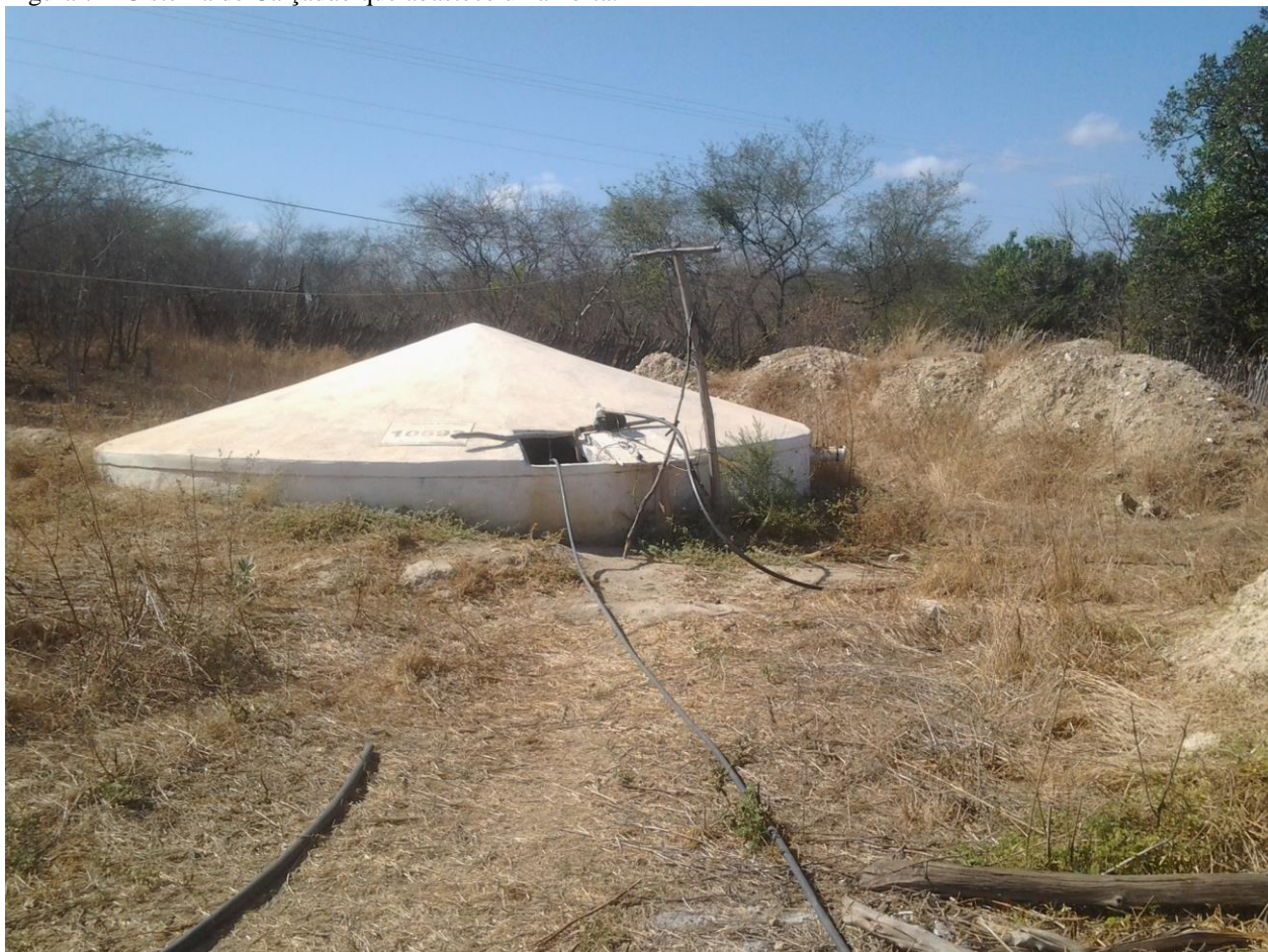
Figura 7 – Cisterna de Calçadão que abastece uma horta.
