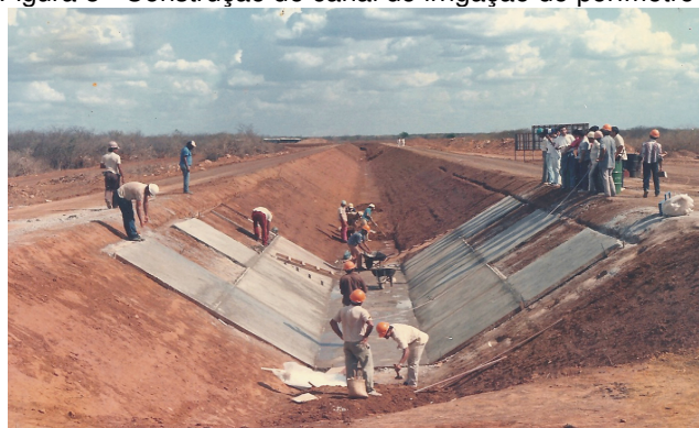
Figura 8 - Construção do canal de irrigação do perímetro
