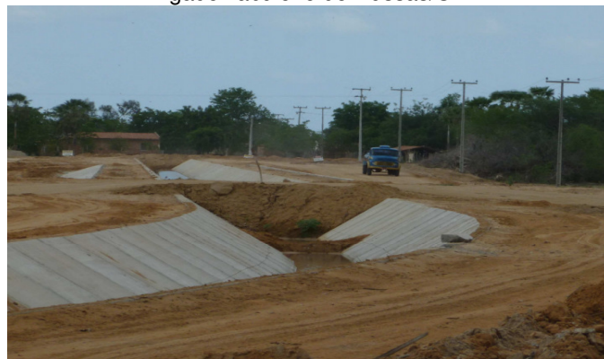
Figura 6 - Construção de canal de irrigação do perímetro irrigado Tabuleiro de Russas/CE
