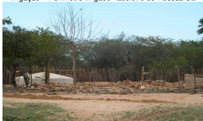
Figura 7 - Destruição de cisterna para construção de canal de irrigação – Perímetro Irrigado Tabuleiro de Russas/CE
