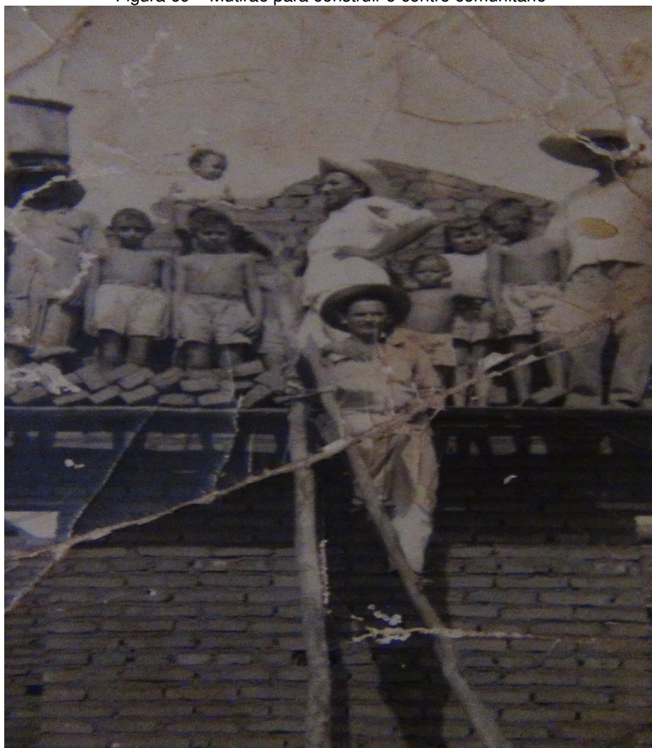
Figura 69 – Mutirão para construir o centro comunitário
